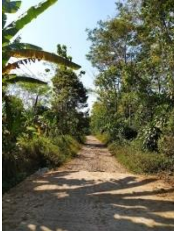
Gambar 12. Kondisi Jalan Utama di Dusun Sampora Sumber: Tim Matching Fund UP
